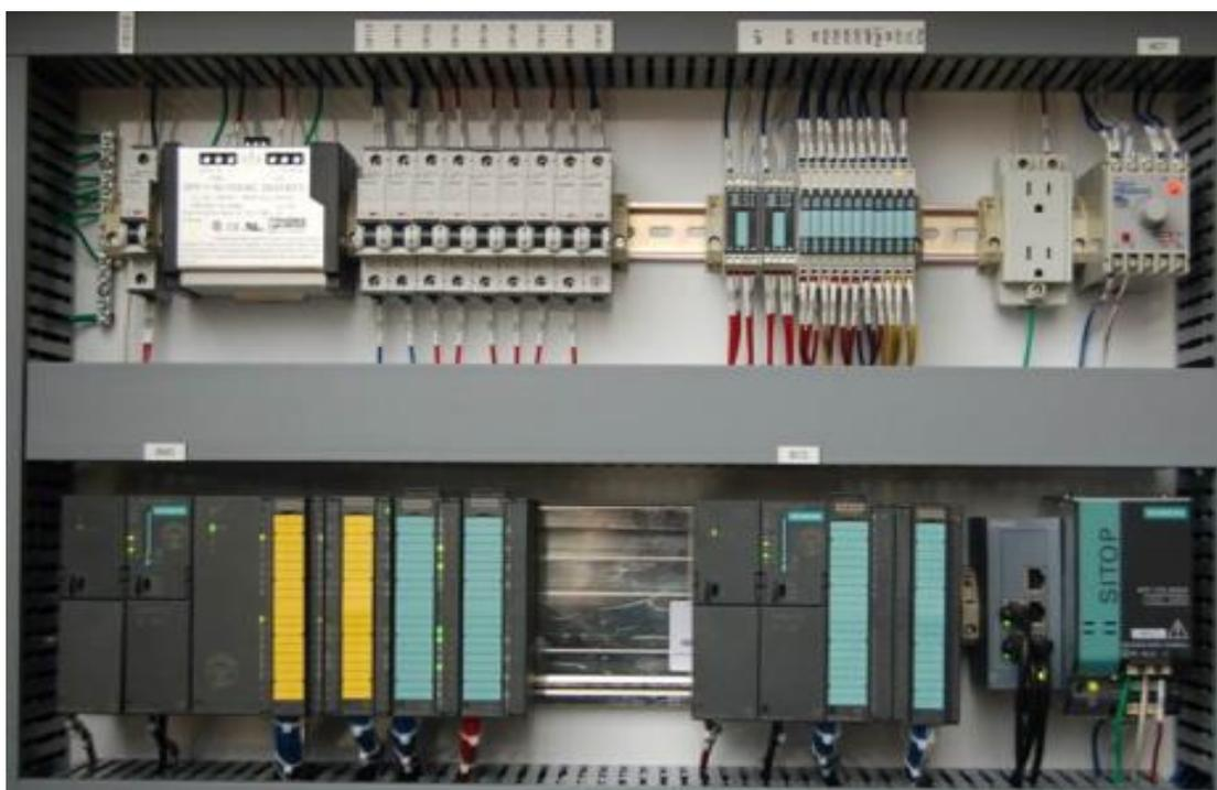
Les automates sont équipés d'un bloc de visualisation centralisant toutes les informations nécessaires au contrôle, au diagnostic et à la maintenance de l'automate et de ses modules, et des fonctions simples de dialogue opérateur.
