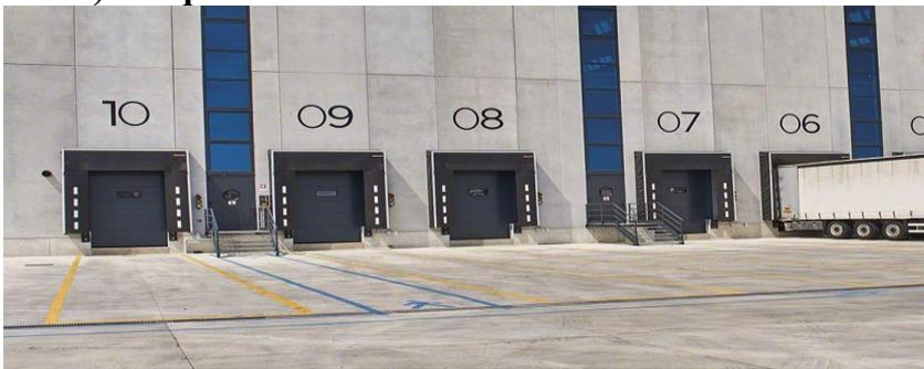
Le quai encastré est idéal pour les manœuvres d'accostage. Son entrée se trouve plus ou moins au même niveau que le seuil des camions et il est légèrement en retrait par rapport au bâtiment pour permettre le drainage des eaux de pluie.
