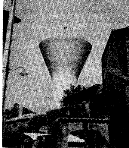
Mire sur château d'eau.
